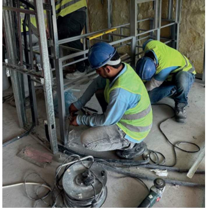
تنفيذ أعمال الهياكل الحديدية للمفاسل والديكورات - فندق حديث
